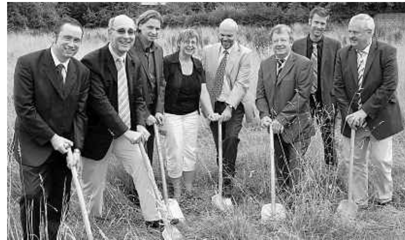
Ambitioniertes Planungsteam: Die Verantwortlichen aus Politik und Wirtschaft gaben mit dem ersten Spatenstich den Startschuss für das neue Fachmarktzentrum in Setterich. Foto: Philipp Baumanns
